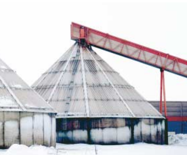
Inbyggda lager begränsar damning och stoftutsläpp i malmhanteringen.
