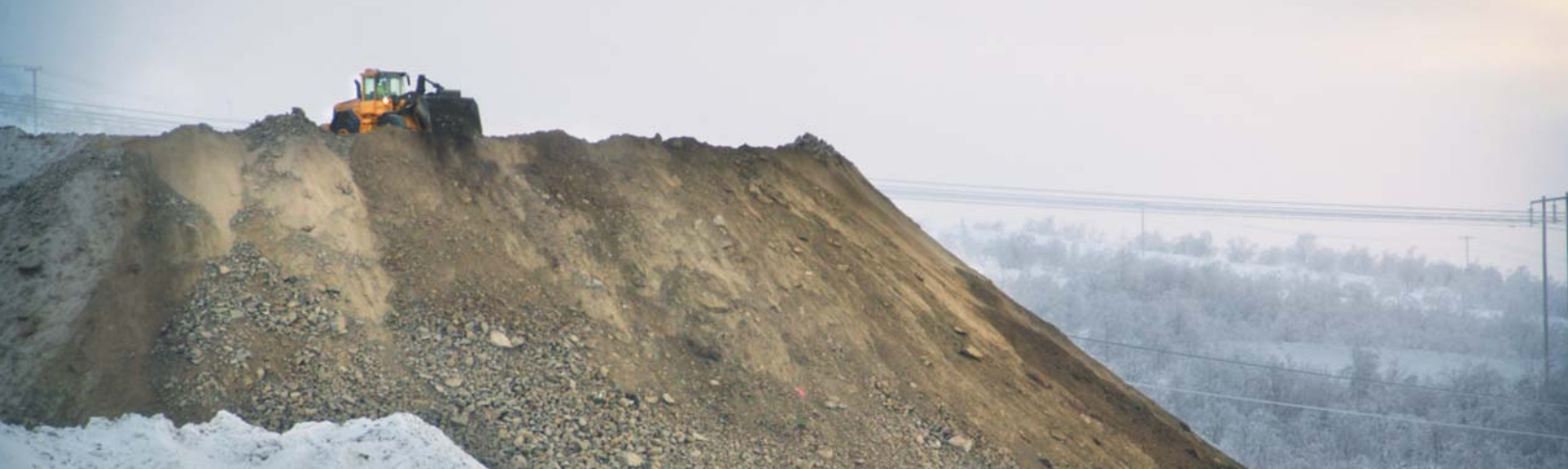
Gruvverksamheten påverkar landskapsbilden. Här schaktas för det nya pelletsverket i Kiruna.
