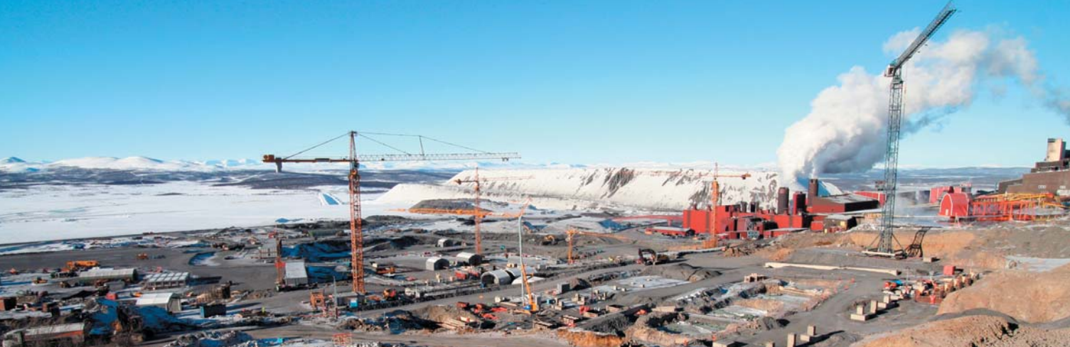
Byggandet av det nya pelletsverket i Kiruna startade direkt efter beslutet i december.
