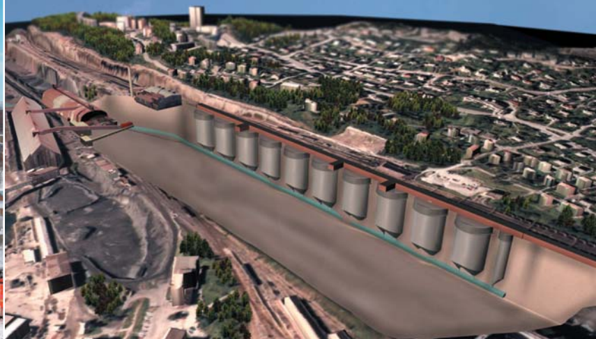
Ombyggnaden av malmhamnen i Narvik har startat. Malmlagren förläggas i silos under jord för att förbättra miljön.
